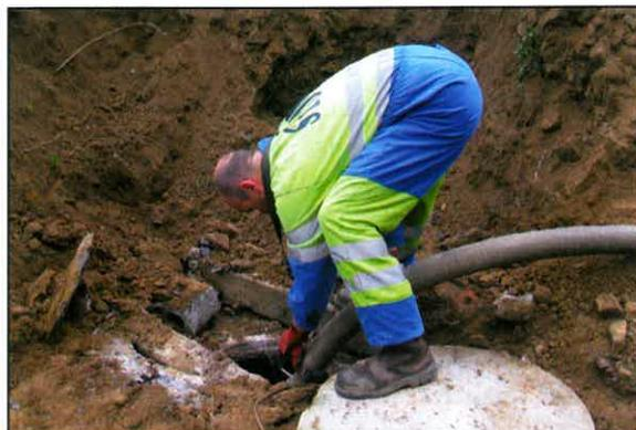
Figure 6. Opération de vidange avant la mise hors service d'un ouvrage
