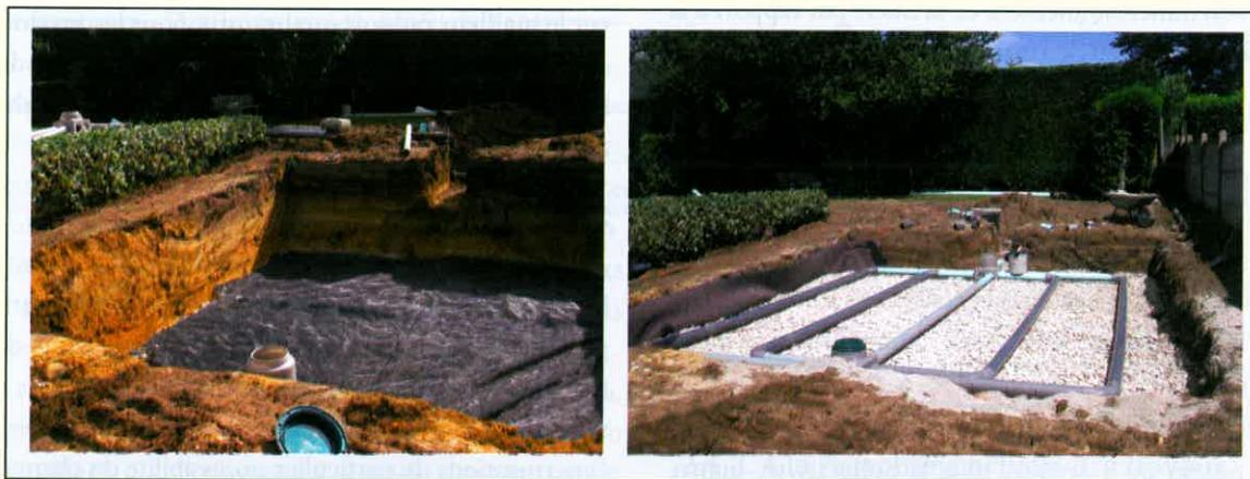
Figure 3. Suivi des travaux lors de l'exécution d'un filtre à sable drainé de 30 m<sup>2</sup> (maîtrise d'ouvrage du SIAEP de St-Jacut-les-Pins)
