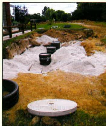
Figure 5. Mise en place d'une fosse toutes eaux, d'un poste de relevage et des tranchées d'épandage (coût de l'opération 7760,42 € TTC avant subventions - maîtrise d'ouvrage Baud Communauté)
